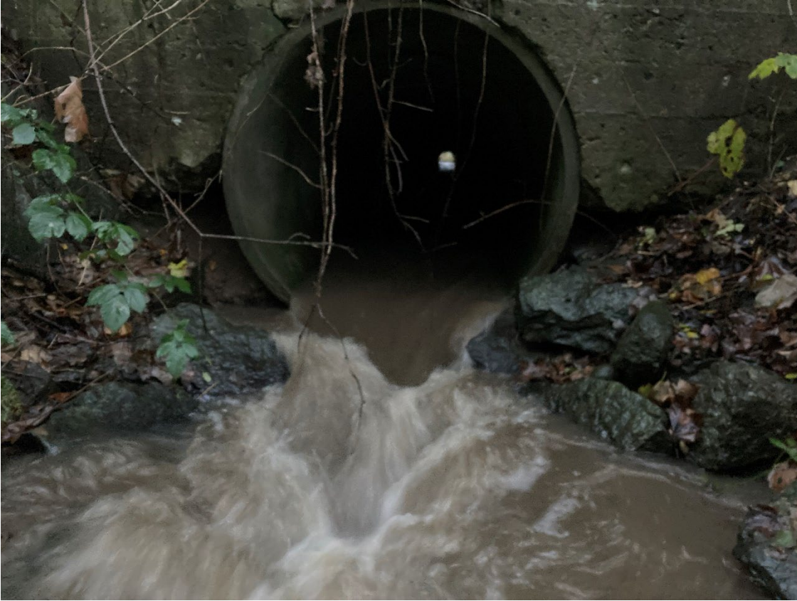
Figur 6. Udløb fra rørledningen, december 2021
